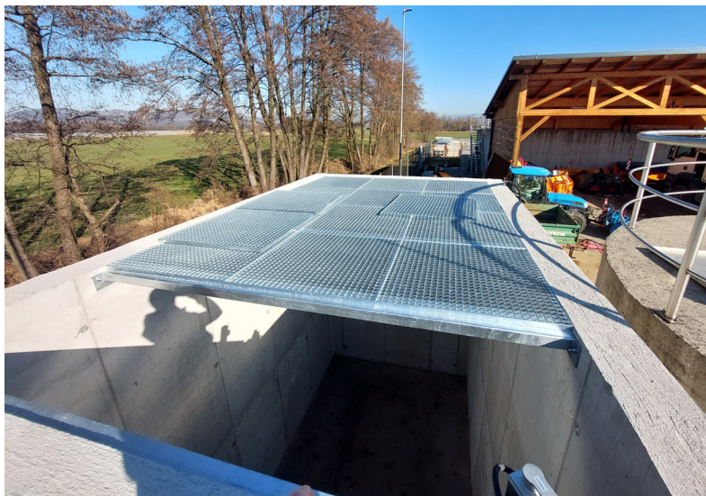
Slika 7: Novi zalogovnik grezničnih gošč
