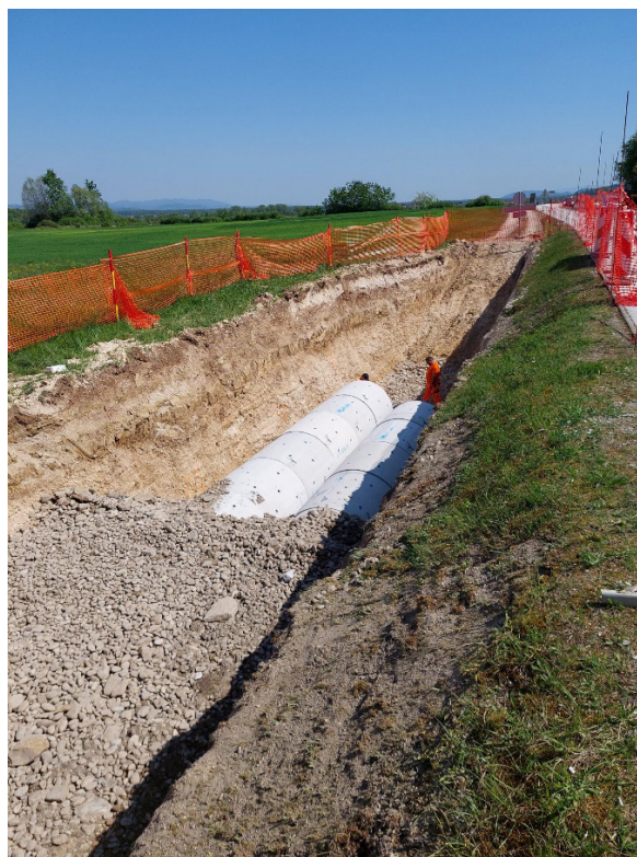
Slika 4: Zaščitna kovinska cev in ponikalno polje
