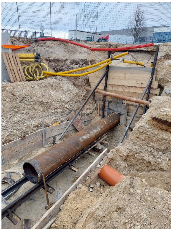
Slika 4: Zaščitna kovinska cev in ponikalno polje
