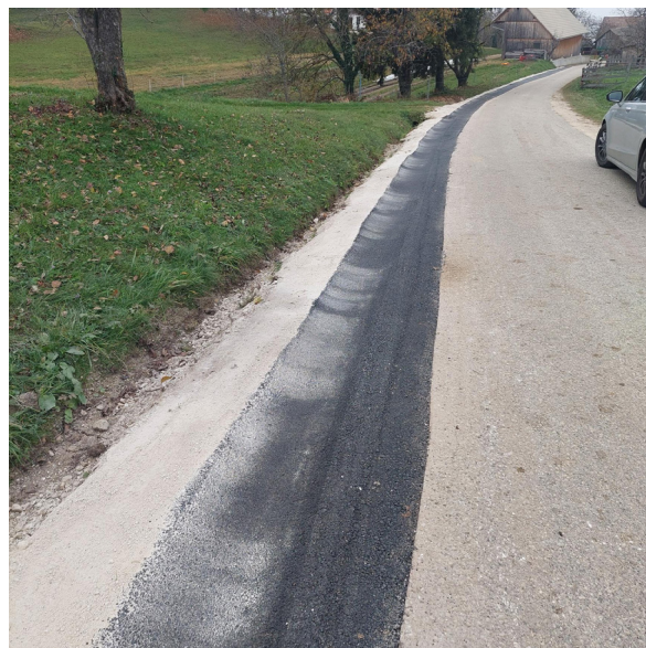
Slika 10: Ureditev asfaltne mulde
